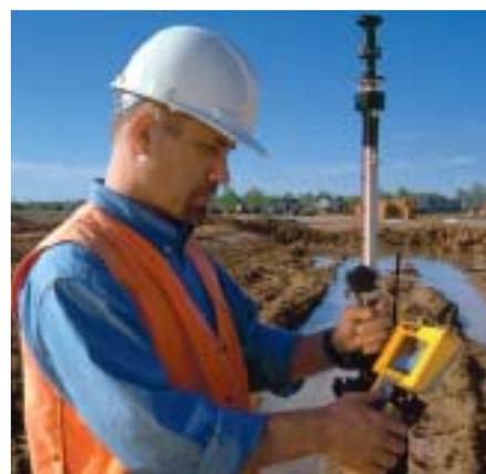
**EFFICIENTE.** Per aumentare la produttività è possibile modificare la Serie 5600 con Autolock™—metodo di misura semi-robotico. Con l'Autolock, lo strumento cerca si blocca e registra l'RMT (active remote positioning target – prisma attivo), così siamo certi che non ci sia il problema che la misura sia presa con altri oggetti riflettenti.
